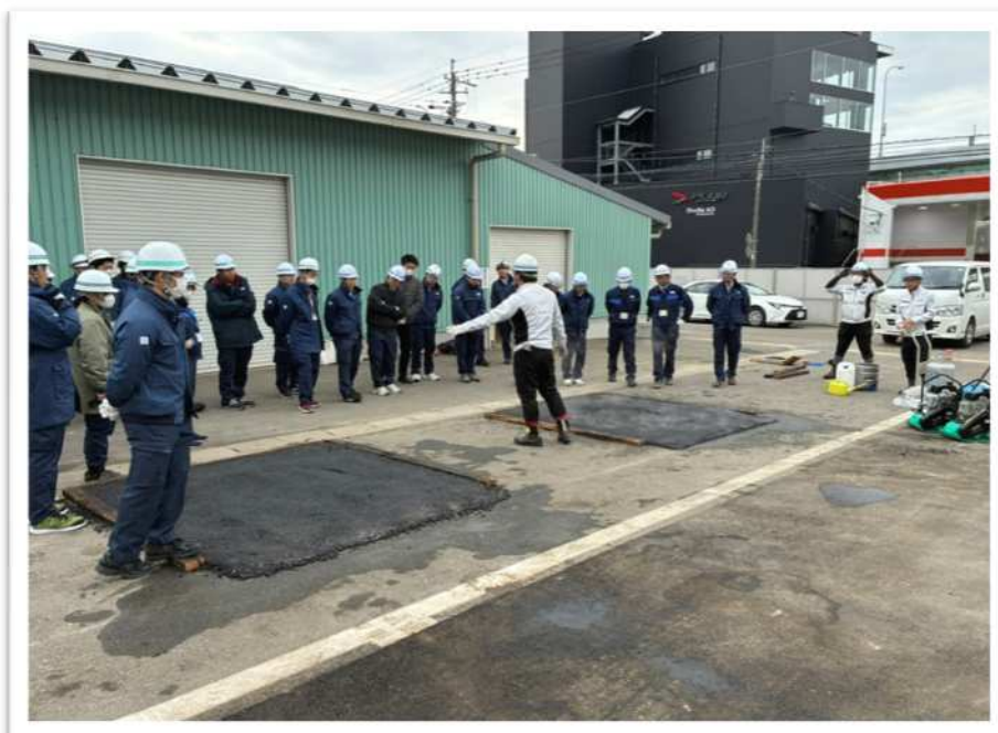
仕上り状況の確認(密粒As、粗粒As)
