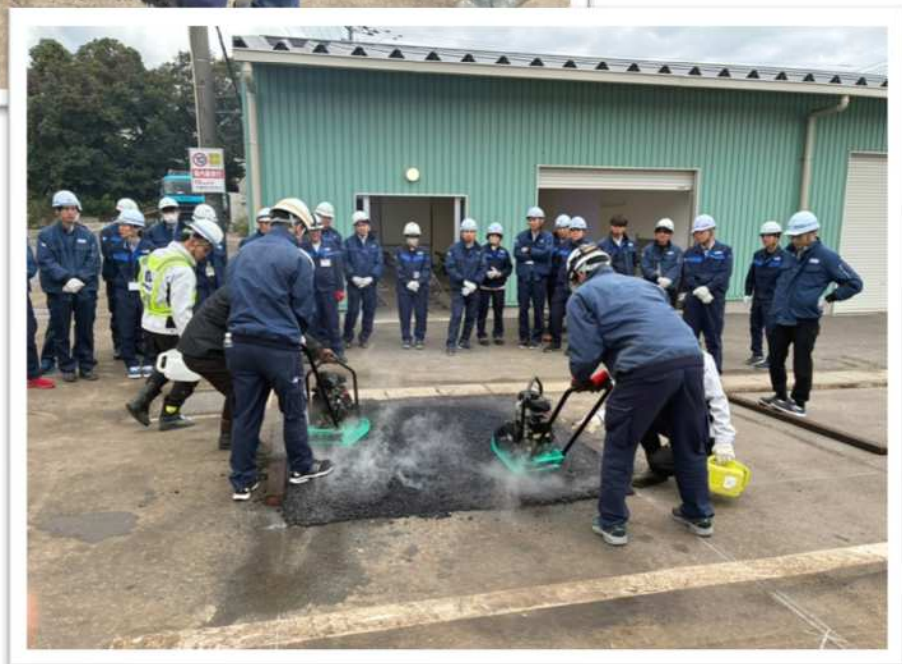
仕上り状況の確認(密粒As、粗粒As)
