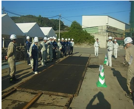
写真の説明：合材の転圧温度による違い目視確認
