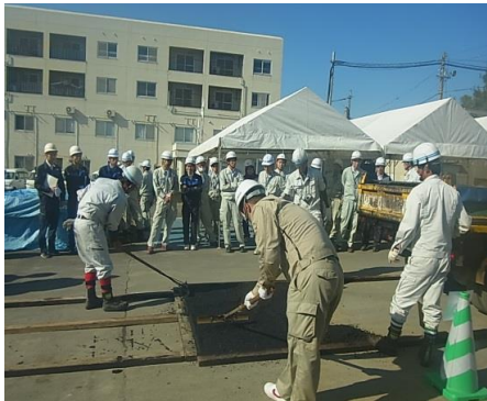
写真の説明：合材敷き均し状況
