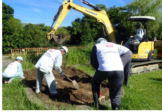
写真の説明：東区 施工中
