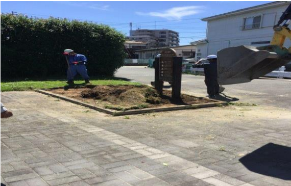
写真の説明：南区 施工中
